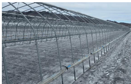
～ ハウス設置作業② ～
