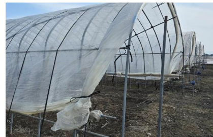
～ ハウス設置作業③ ～
